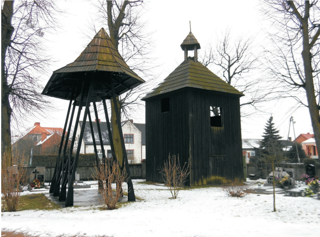
Fot. 2. Drewniana dzwonnica z sygnaturą przy kościele w Szkaradowie, luty 2015 r. Fot. M. Smolnicki
